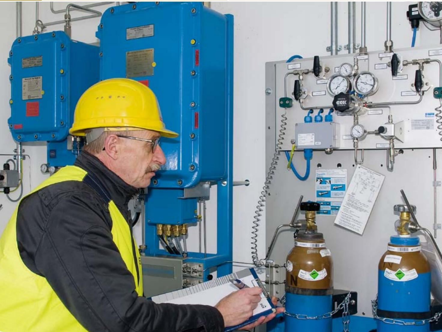
Eichtechnische Inbetriebnahme der Biogaseinspeisung in Angermünde
